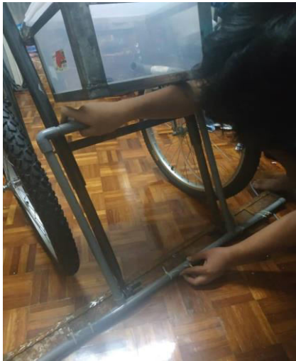
Rajah 3.5.2 (a): Proses memasang paip PVC dan paip hos.
