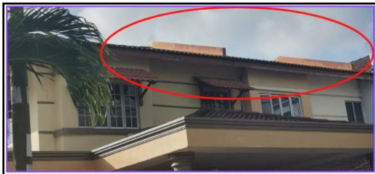
RAJAH 27 : Dinding Pemisah
