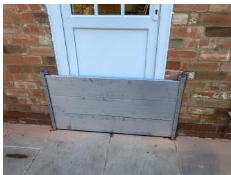
Rajah 1.6 Contoh Flood Door Barrier yang sedia ada
