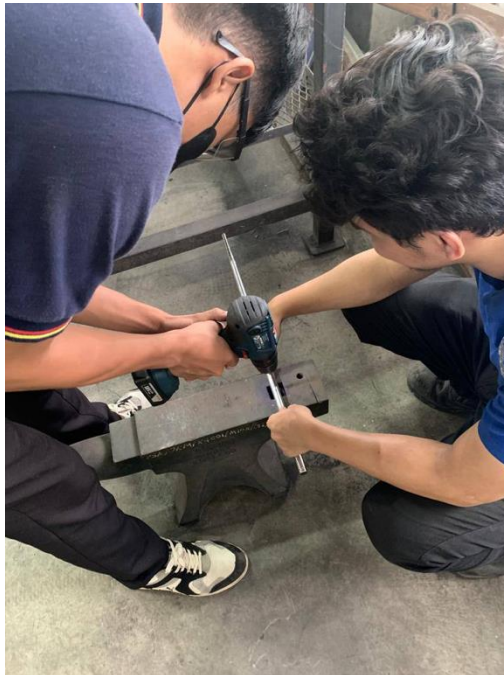
(Rajah 3.3.2 : MENEBUK LUBANG DENGAN MENGGUNAKAN GERUDI TANGAN)
