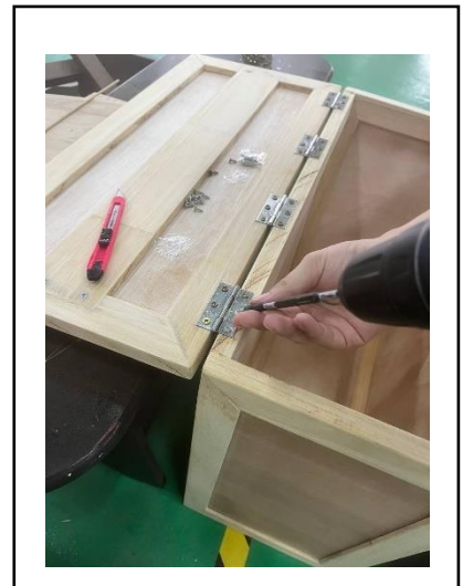
Rajah 74: Proses Memasang Skru Hinges
