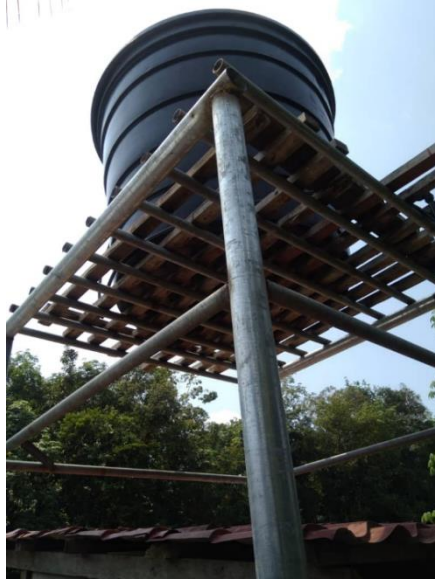
Rajah 4.31 Gambaran yang lebih dekat jenis atau kedudukan tangki di kediaman
