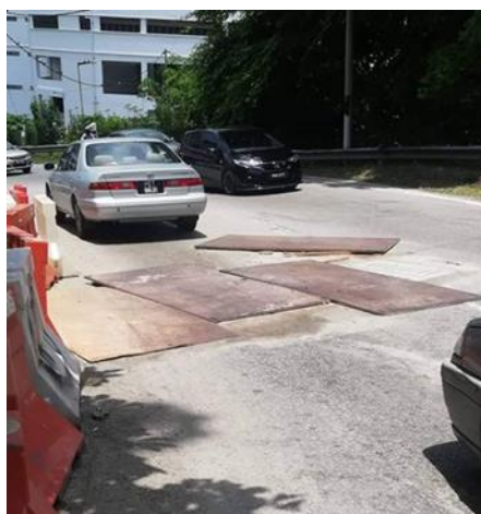
Rajah 2.1: Kaedah plat keluli di jalan.
