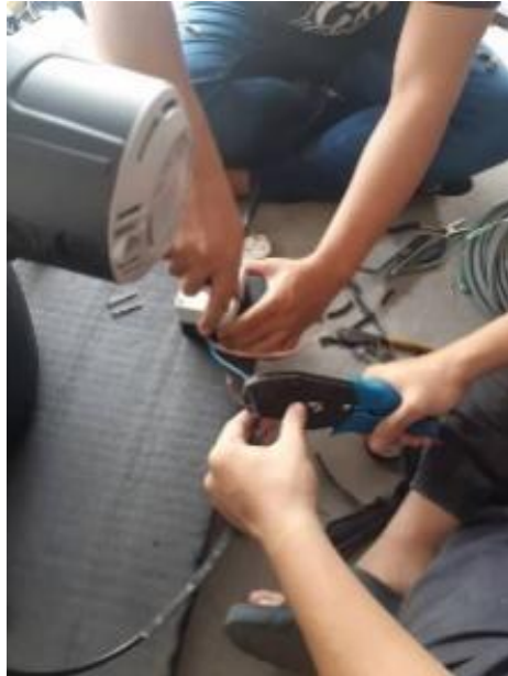
Rajah 3.6.10 Aktiviti pemasangan emergency stop suis
