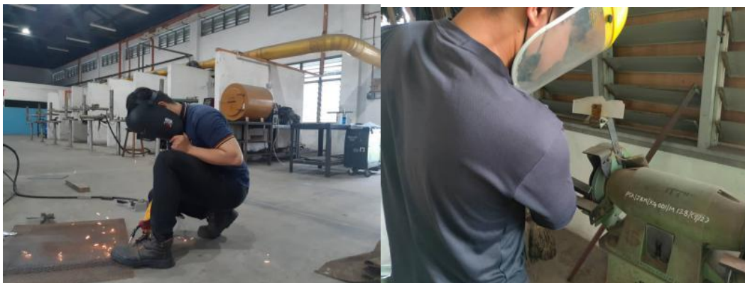
Rajah 3.6.2 Proses kimpalan dan “grinding” asas tapak serta pemegang
