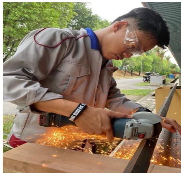
Image 3.5 (d) Showing cut the iron angle.
