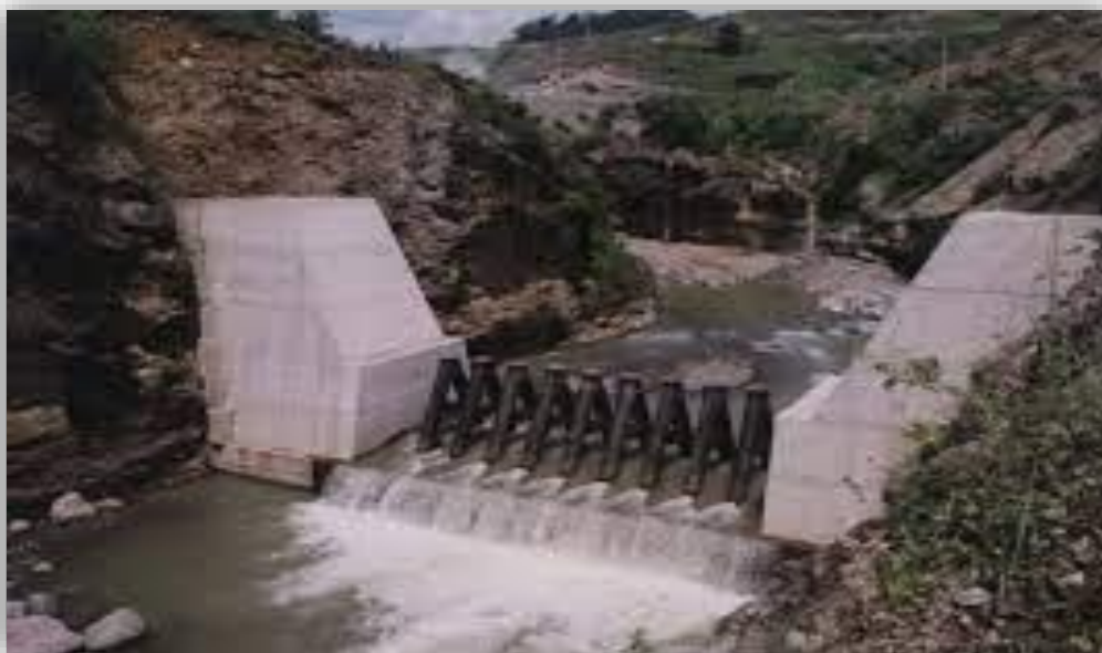
Rajah 4.3.9 Empangan Sabo yang dibina di jepun.
