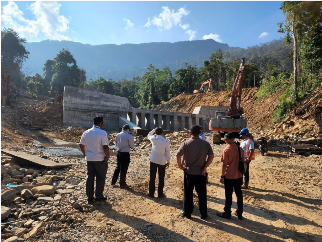
Rajah 12. Menunjukkan pembinaan “Sabo” yang dijalan di Yan, Kedah.
