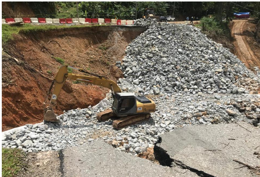
Rajah 4.6.5: Kerja baik pulih cerun Jalan Bentong-Raub
