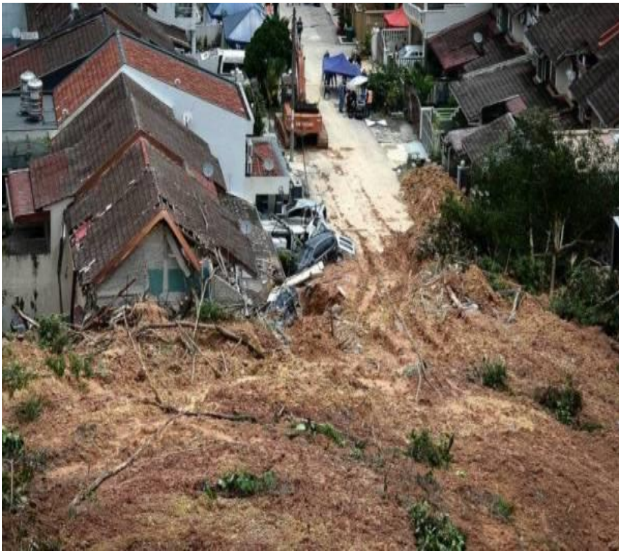
Rajah 2.5.1:Kegagalan Cerun Di Taman Bukit Permai,Ampang, Selangor Akibat Hujan Berterusan
