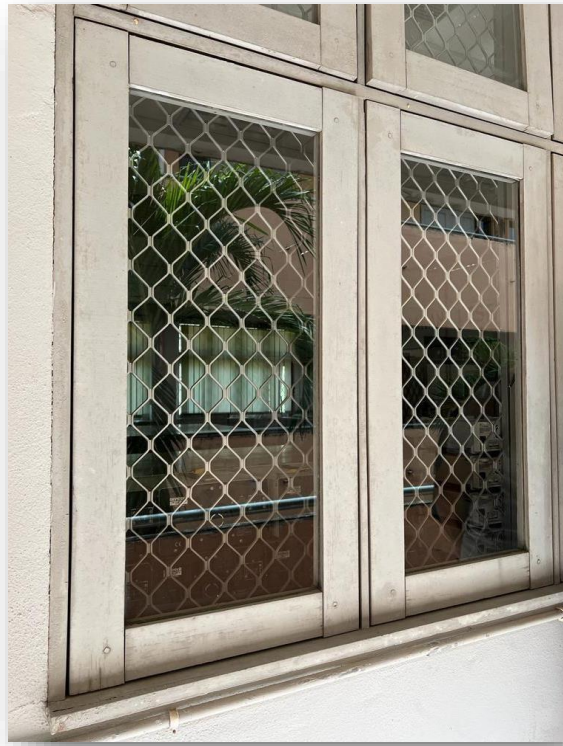
Rajah 20: Bahan yang digunakan untuk tinted adalah polyethylene terephthalate
