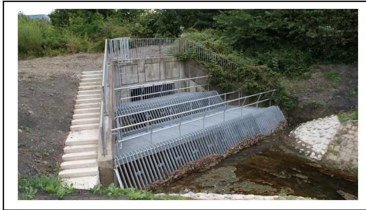
Rajah 2.10.1 Perangkap Sampah Jenis 'Trash Screen'
